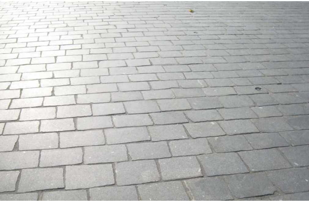
Referentie natuursteen bovenzijde gezaagd, zijkanten behakt
